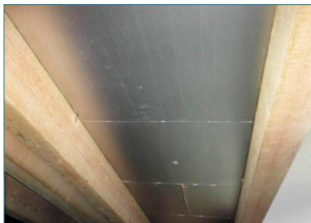
Рисунок 1: Внутренняя часть двускатной крыши: стропила и слой теплоизоляции
